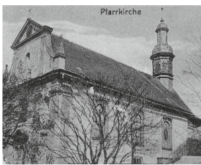
Außenansicht der Kirche vor der Erweiterung. Klar zu erkennen ist der Dachreiter über dem Chor.
