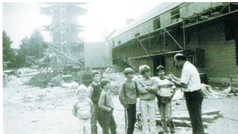
Bau des evangelischen Gemeindezentrums St. Markus in Estenfeld.
